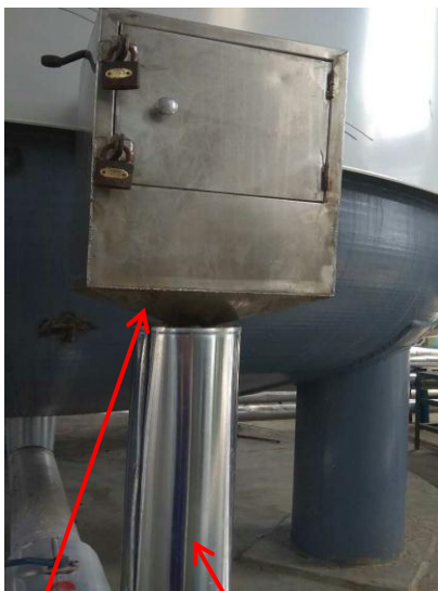
漏斗形收集器伸入下接管形成封闭系统
